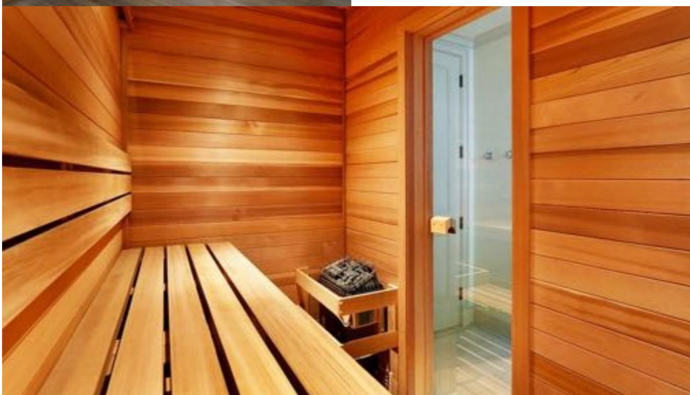
Площадь помещения для домашней сауны №15 распределена таким образом (см. план возводимых перегородок), чтобы разместить печь в глубокой части. При этом полки по длинной стене могут быть в один уровень, а по короткой стене - в два уровня.
